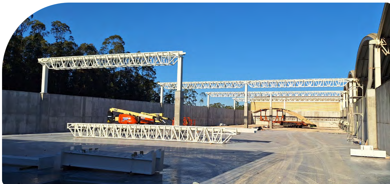
Figura 20 – Construção da Pós-compostagem
